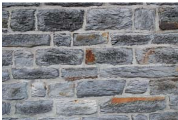
Maçonnerie en moellons équarris, ancien presbytère de Goronne. CL
