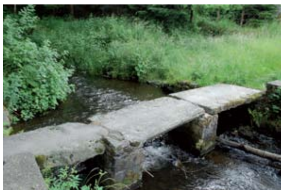
Pont de Tiennesses formé de grandes dalles ( longueur: 2,05 mètres, largeur: 1,25 mètre, épaisseur: 12 centimètres ) de schiste. CL.
