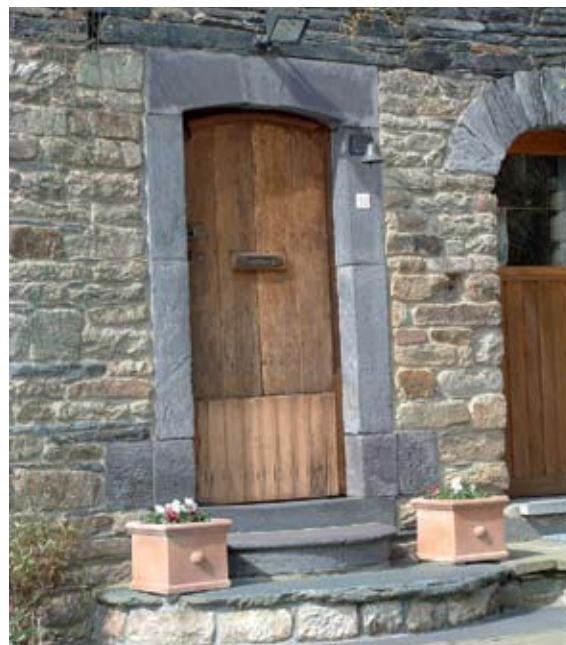
Encadrement de porte, La Comté. Linteau cintré à la base, avec trigramme IHS et date gravés dans la fausse-clé. Perron et dalle de seuil à la base. Mur de façade avec majoritairement de l'arkose pour le soubassement et des moellons plats de schiste ailleurs. Notons le moellon de schiste plus long que le linteau au-dessus de celui-ci. La Comté. EG
