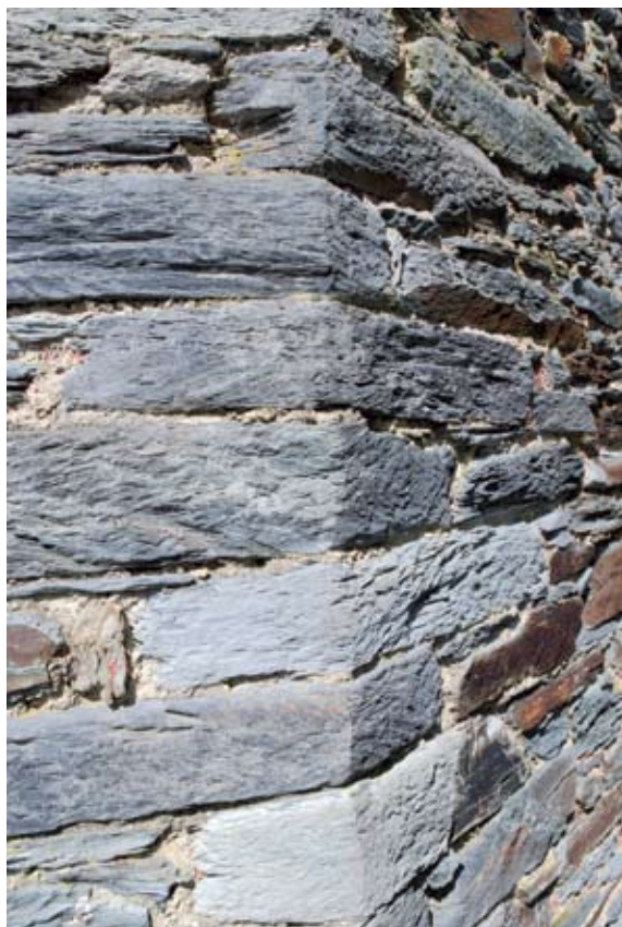
Murs à angle de 135° de la glacière de Hermanmont. CL
