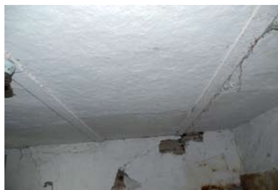
Dalles de schiste formant plafond et reposant sur des poutrelles. ( Joubiéval, Vielsalm ). CL
