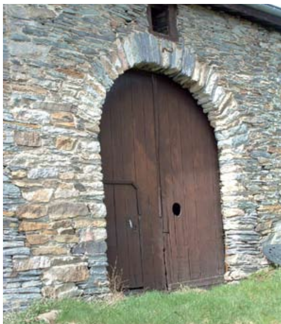
Baie de porte de grange formée de moellons de schiste et de grès, La Comté. Petite fenêtre en encadrement de bois au-dessus de la voussure. EG
