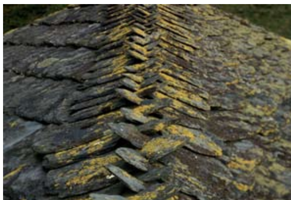
Lignolet réalisé en ardoises « cwèrbâs ». CL.
