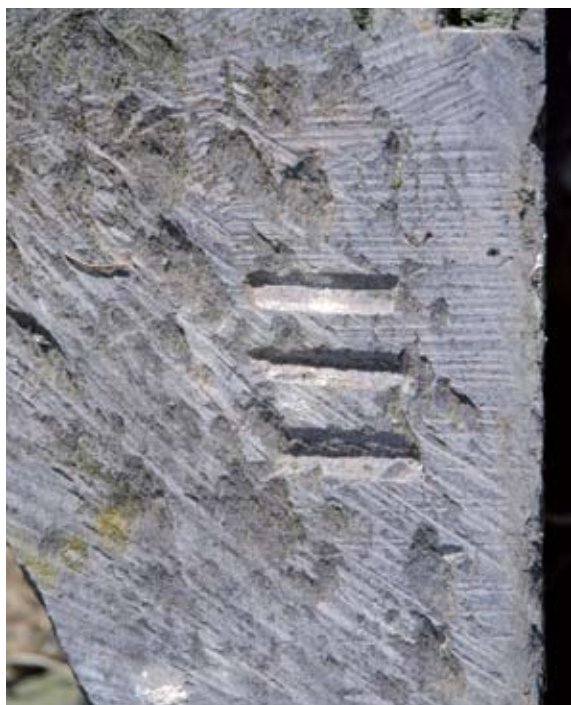
Marques d'assemblage en creux de 4 cm de longueur à la base d'un pied-droit. CL
