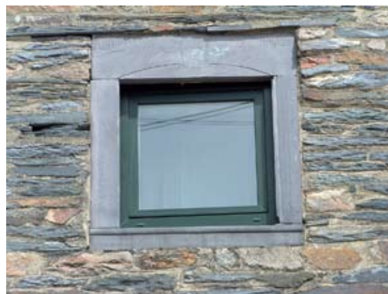
Encadrement de fenêtre, avec linteau droit, ciselure d'un faux cintrage et d'une fausse-clé. Nez arrondi en avant de la tablette. Petit ressaut en goutte-d'eau en plaquettes de schiste au-dessus du linteau. La Comté. EG
