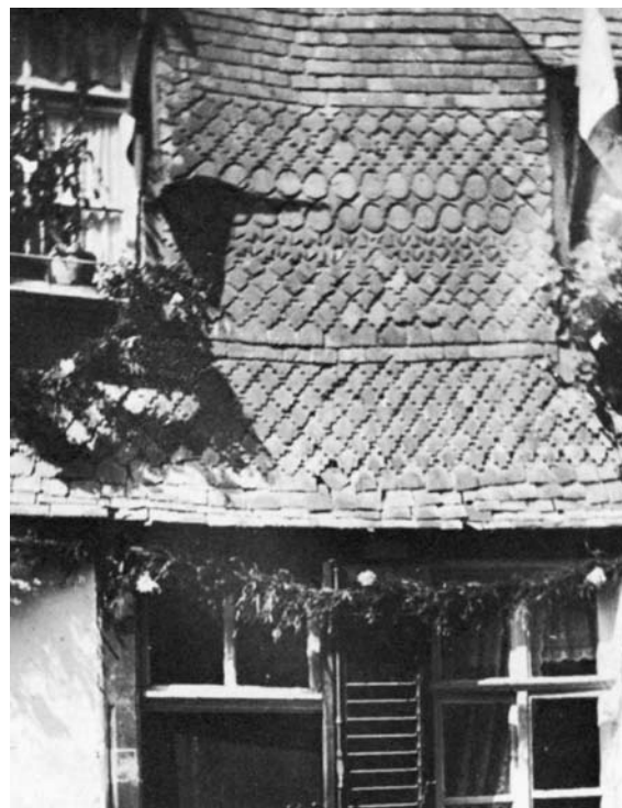
Façade essentée, rue Basse à Stavelot. Reproduction d'après d'Otreppe de Bouvette, 1976
