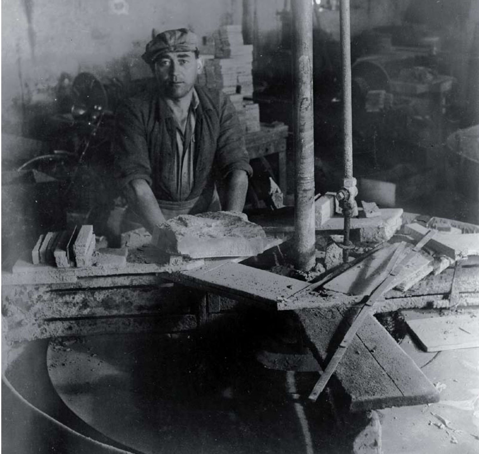
Ouvrier de l'atelier Nickelman à Salmchâteau travaillant au lapidaire. On y voit l'axe vertical d'entraînement de la plaque en fonte. Le travail au lapidaire est divisé en zones séparées par des planches et servant de postes de travail pour plusieurs ouvriers polisseurs. Photo non datée. Archives du Musée du Coticule. Val du Galin, 1984.
