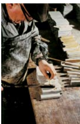
Opération de collage au fer des pierres à aiguiser réalisée par Joseph Minet. Photo A. Lejeune. Archives du Musée du Coticule.
