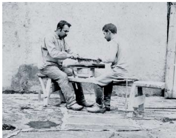
Découpage des blocs de coticule à la scie à main. Les ouvriers sont assis sur un « bâdet ». Les photos du haut et du bas dateraient des années 1900-1910. Photo du milieu; la découpe a été mécanisée. Gros plan sur la lame de faux redressée pour cet usage. Archives du Musée du Coticule.
