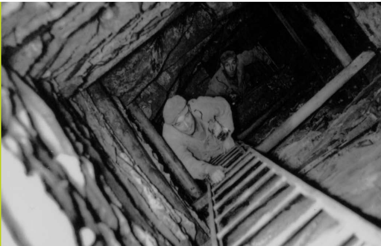
Remontée d'un ouvrier mineur par une échelle métallique. Le bure est de section rectangulaire et les murs sont constitués de pierres sèches. La partie droite, sans échelle permet la montée et la descente des tonneaux métalliques. Photo A. Lejeune. Archives du Musée du Coticule.
