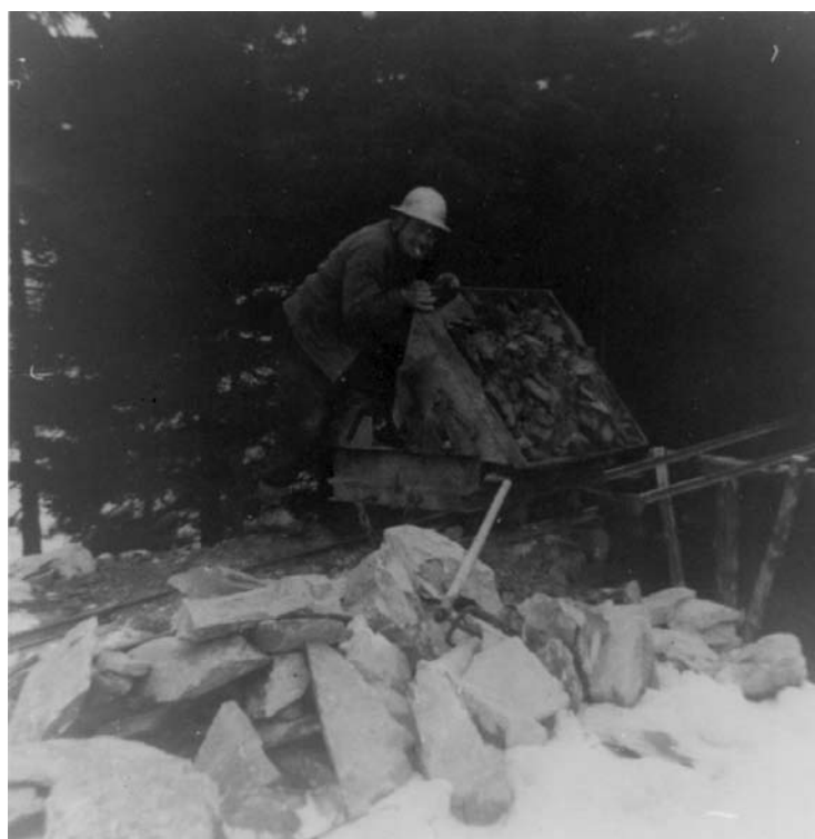
Haut : Déversement d'un tonneau métallique et transfert des pierres brutes dans un wagonnet. Photo A. Lejeune. Archives du Musée du Coticule.
