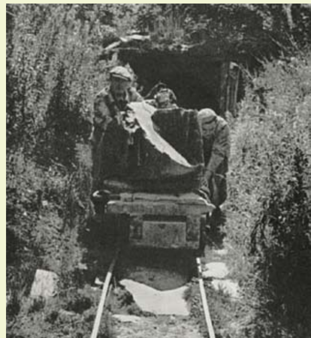
Ouvriers poussant un wagonnet chargé de blocs de phyllade ardoisier au sortir de la galerie de Roquèves. Photo non datée, Extrait de: «Luxembourg belge», 1951. Photo 8: L'ardoisière, sortie d'une galerie (L. De Meyer).
