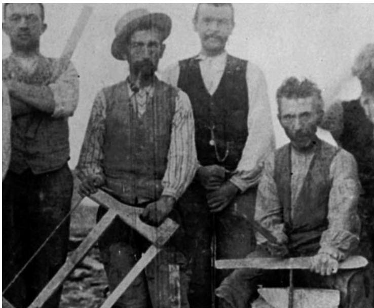
Fendeurs d'ardoise prenant la pose à l'extérieur de leur atelier et montrant leurs outils de travail. Photo non datée, collection privée.
