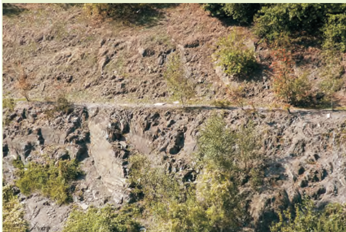
Roches tectonisées du talus est du Plan Incliné.
