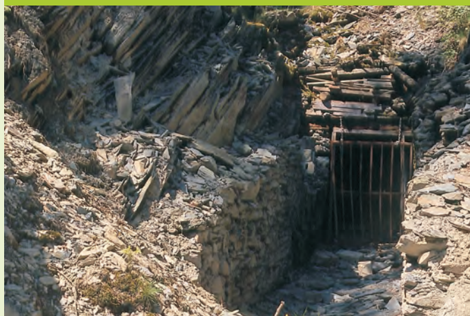
Entrée de l'exploitation ardoisière du Coreux.
