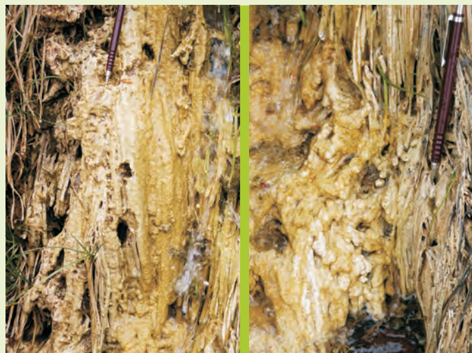
Aspect concrétionné, stalactitique et fistuleux des dépôts du Cron de Montauban.
