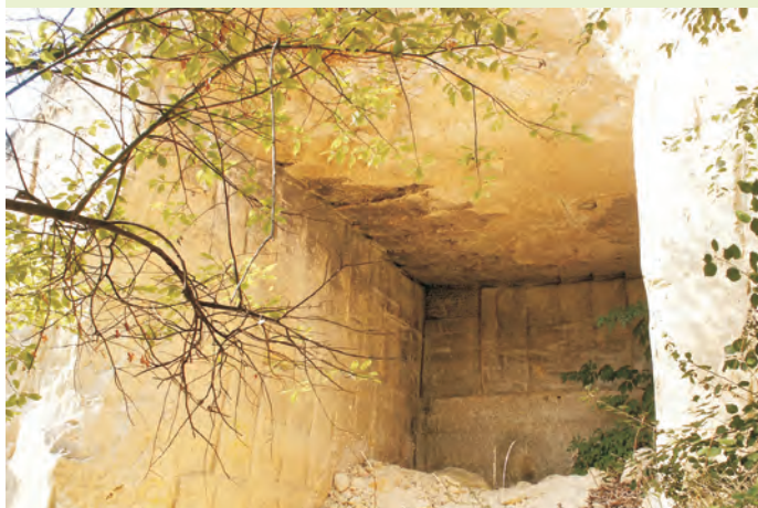
Début d'exploitation souterraine de tuffeau.
