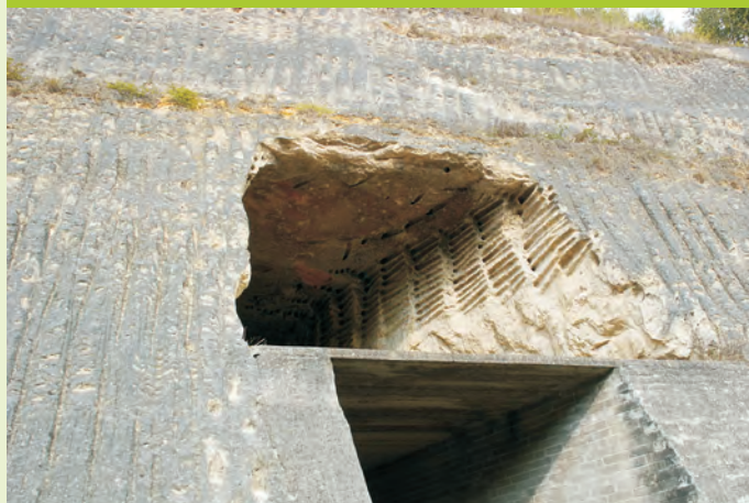
Galerie d'exploitation souterraine de tuffeau à perforations horizontales.
