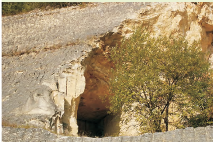
Entrée de galerie d'exploitation souterraine de tuffeau.
