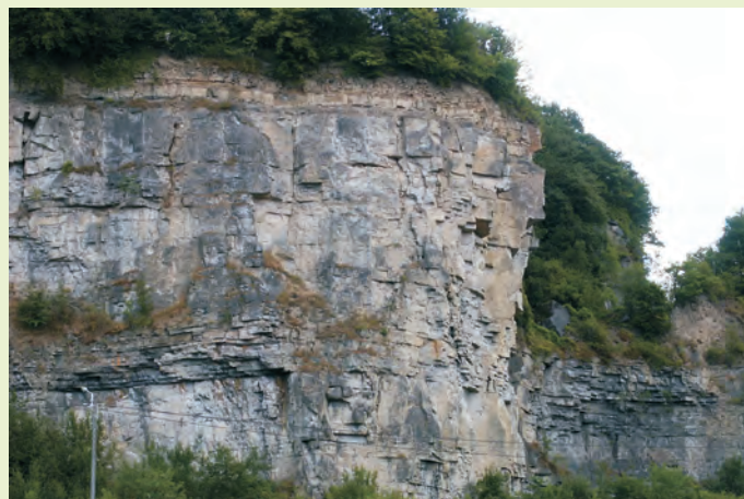
Partie sud de la carrière Thays.
