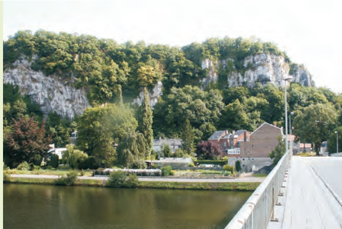
L'ensemble escarpé au sud du pont de Namèche.
