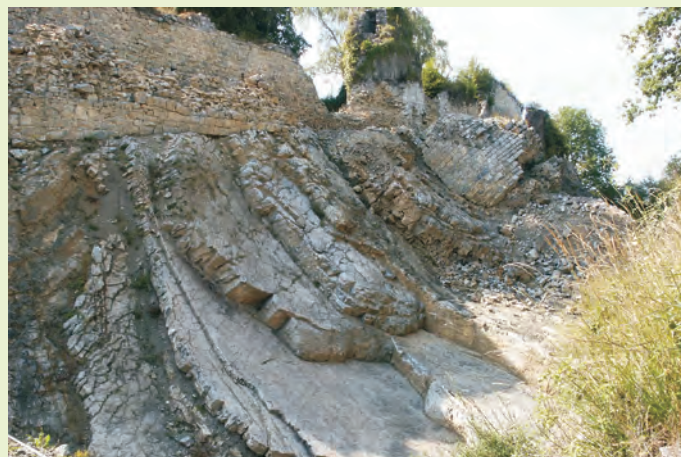
Poilvache, affaissement d'une tour.
