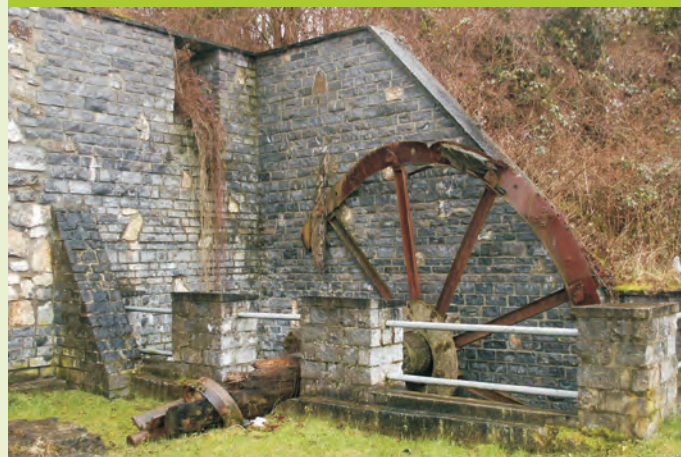
Vestige de l'exploitation marbrière.
