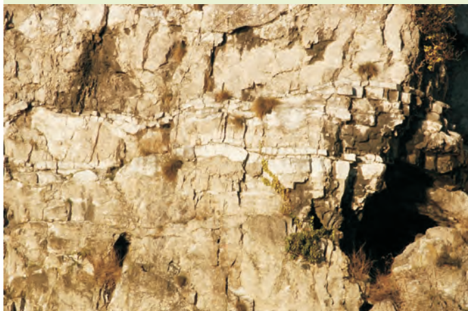
Bancs à stratification quasi horizontale.
