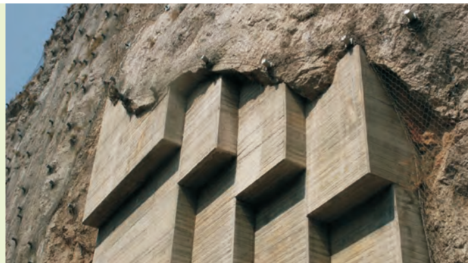
Soutènement par contrefort en béton.
