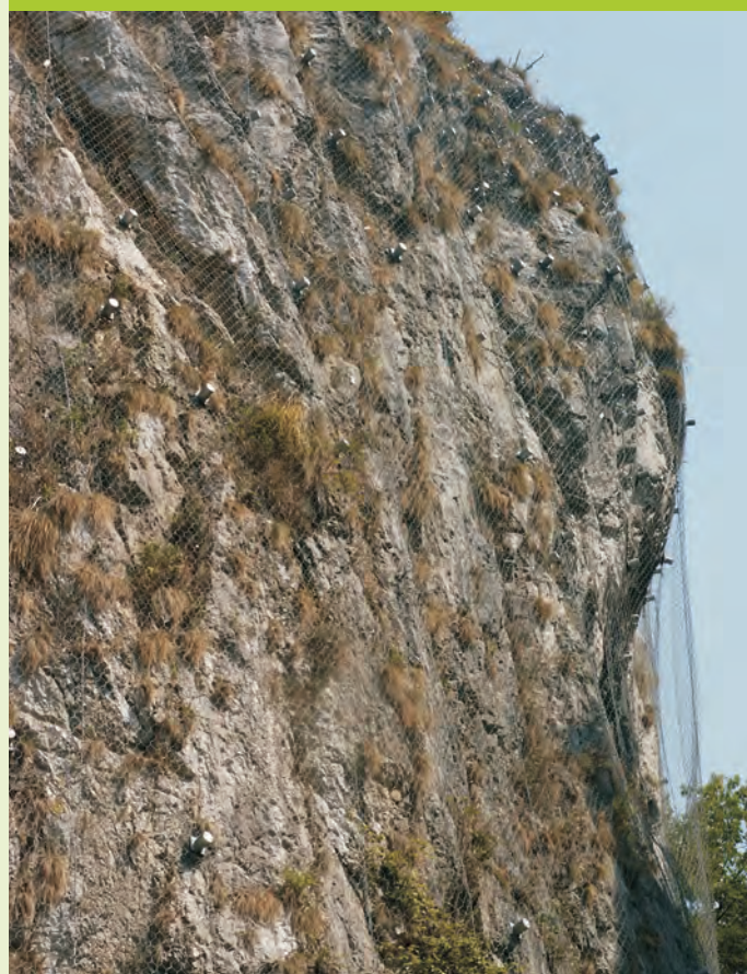
Boulonnage et treillis métallique.
