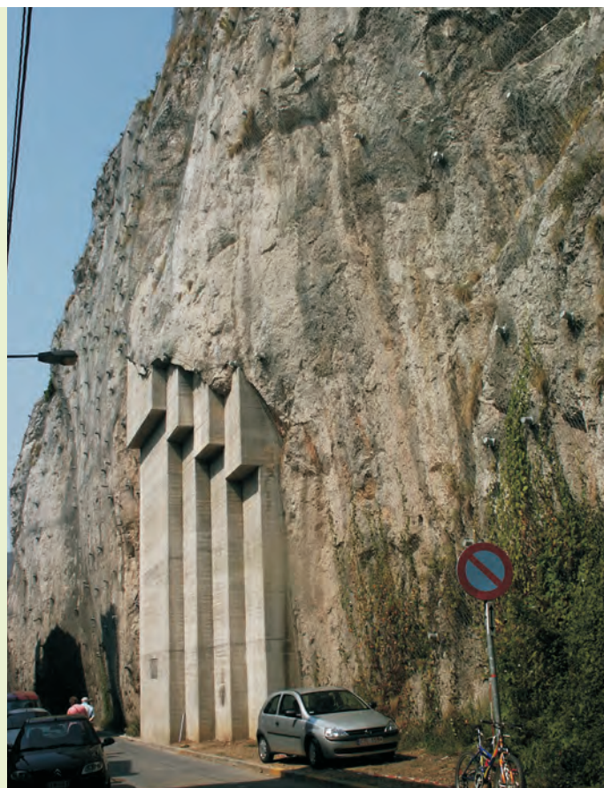
Soutènement par contrefort en béton.
