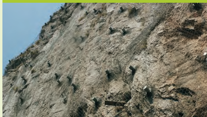
Boulonnage et treillis métallique.
