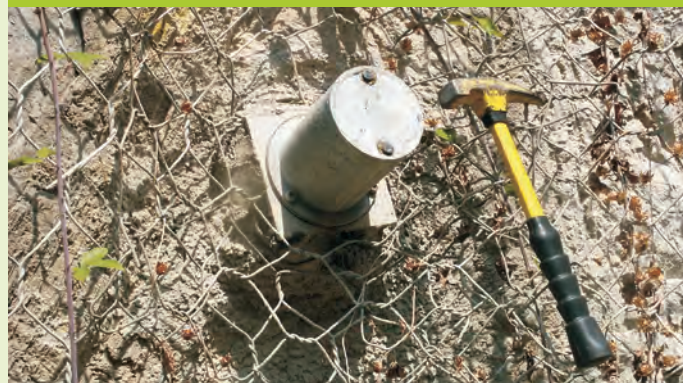
Coiffe d'une barre de boulonnage.
