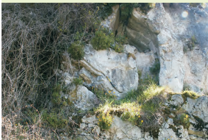
Synclinal le long de la route N92.
