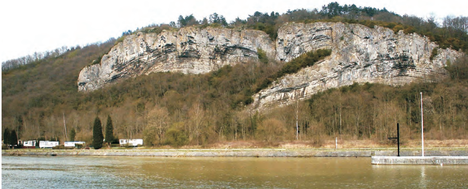
Rochers de Chamia, vue générale.
