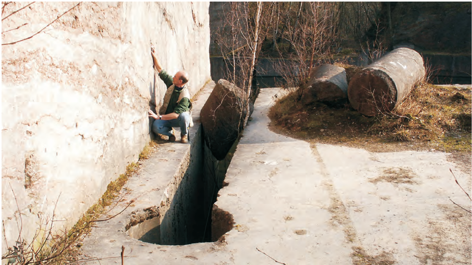
Puits foré pour le passage du fil hélicoïdal.
