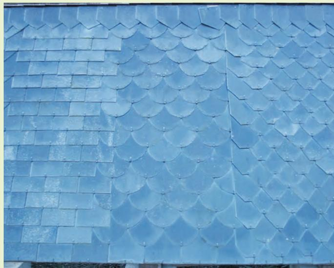
Différentes formes d'ardoises utilisées en toiture.
